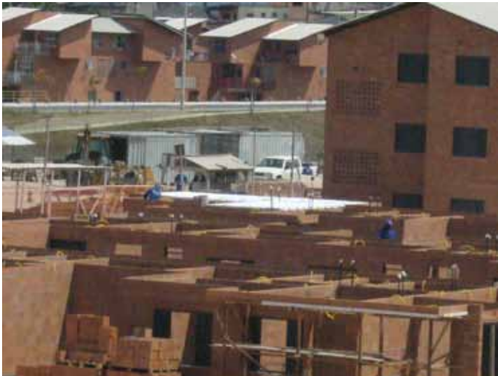
Prosamim: construcción de la nueva tipología con la antigua al fondo
