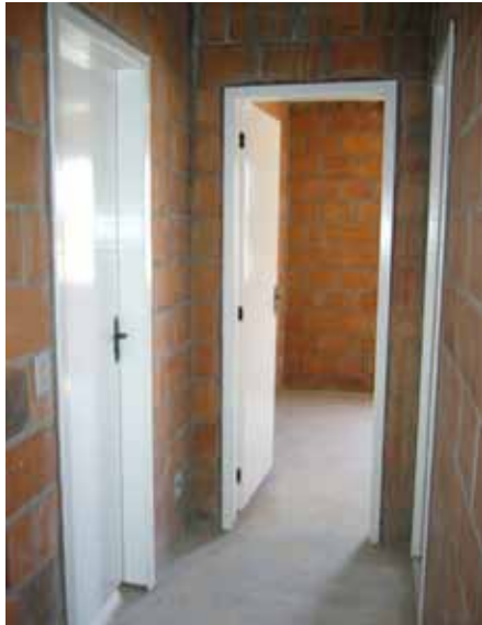
Interior de unidad del Prosamim en construcción
