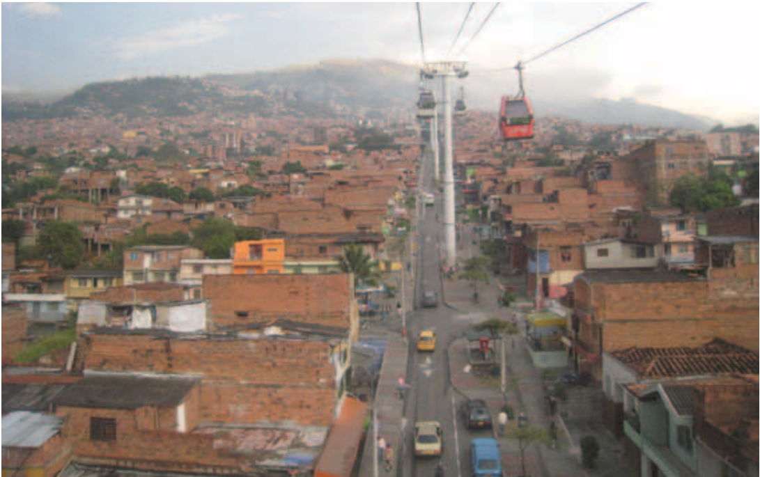
El metrocable brinda una solución original para el transporte colectivo y la integración socioespacial entre los asentamientos informales periféricos y las áreas centrales de Medellín, Colombia.
